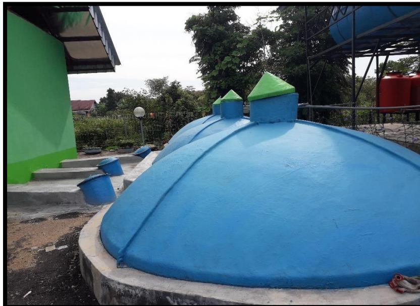
**Gambar 3.3** Reaktor Biogas
