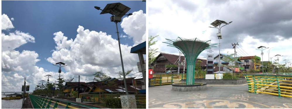
Gambar 4.12. Kondisi Jaringan Listrik
