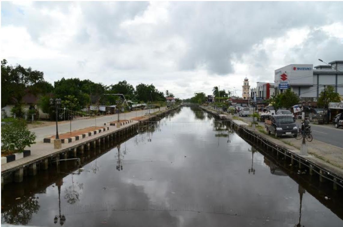
**Gambar 4.9. Saluran Sungai Jawi Dinding Turap Beton**
