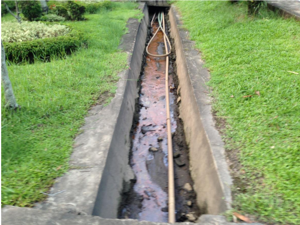
Gambar 5.5. Salah Satu Saluran yang Alirannya Terhambat dan Perlu Dinormalisasi
