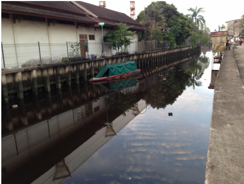
Gambar 4.5. Saluran Parit Tokaya Dinding Turap Beton
