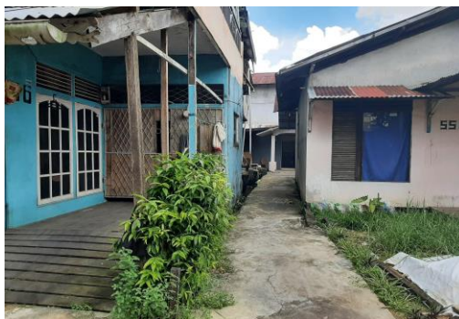
Gambar 3. 16 Kondisi Bangunan yang Berada di Belakang Kavling Rumah
