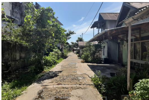
Gambar 3. 15 Kondisi Bangunan yang Menghadap Jalan Sumber: Hasil Survey , 2021
