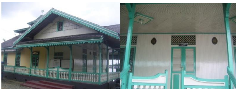
Gambar 3. 2 Kondisi Masjid Baitul Makmur
