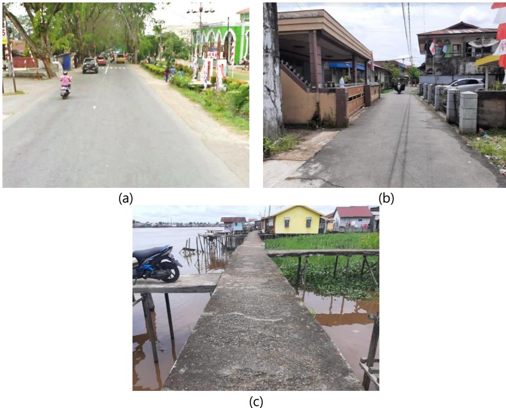
Gambar 3. 26 Kondisi Jalan (a) Jalan Imam Bonjol (b) Gg. Mendawai Tengah (c) Gg. Mendawai Laut Sumber: Hasil Observasi, 2021
