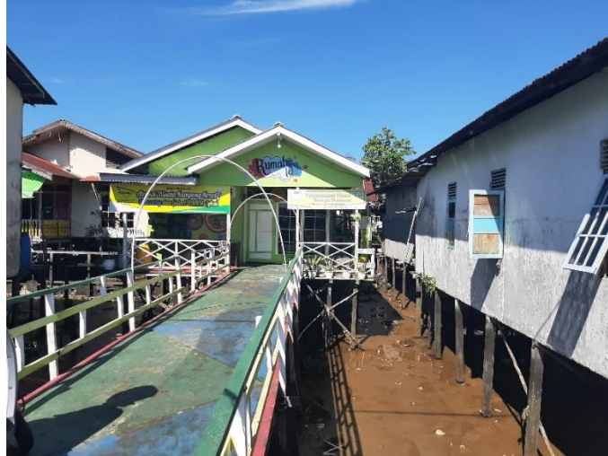
Gambar 4. 12 Kondisi Rumah IDE
