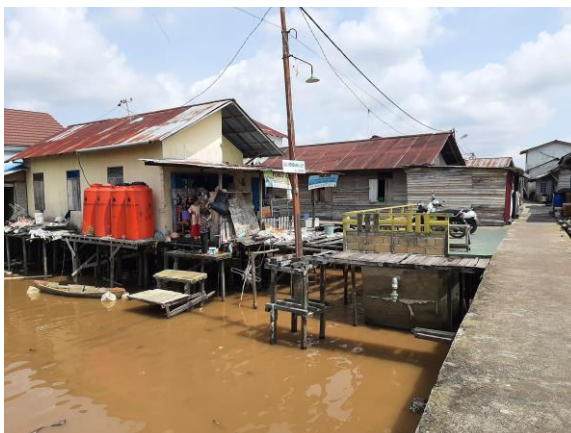
Gambar 3. 13 Kondisi bangunan yang menghadap Sungai Sumber: Hasil Survey , 2021
