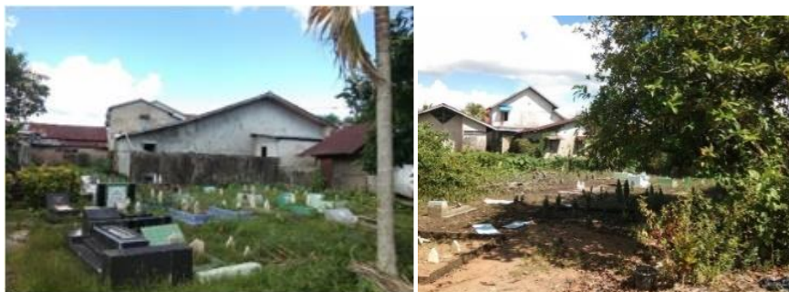
Gambar 3. 23 Kondisi Lahan Pemakaman Sumber: Hasil Survei Primer, Tahun 2021
