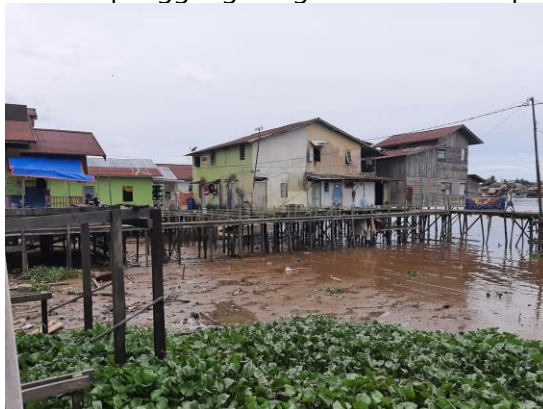
Gambar 3. 14 Kondisi Bangunan yang Membelakangi Sungai Sumber: Hasil Survey , 2021
